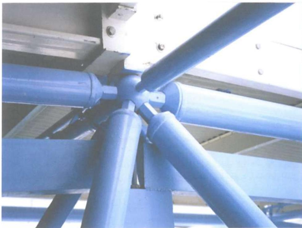
شکل (۴)- یک نمونه از سیستم گوی و لوله
